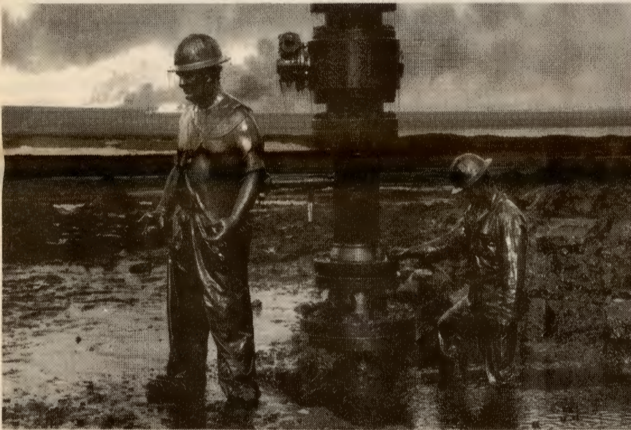
Det nye brønnhodet settes på plass. Nå er det mulig å sprøyte inn boreslam og «drepe» den gamle brønnen. Burgan feltene i Kuwait, 1991.
