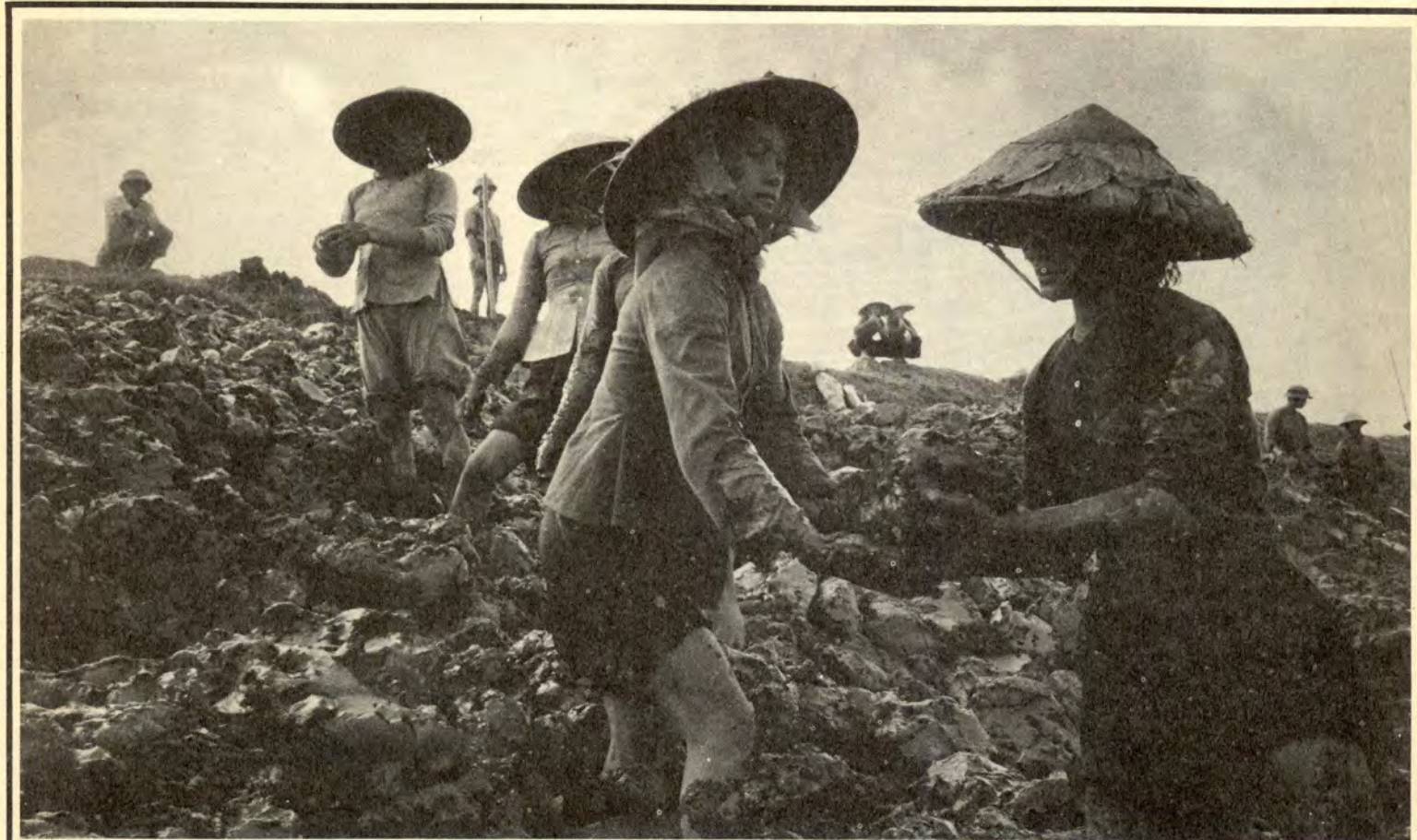
●NORDVIETNAM drabbades inte av översvämningar efter USA-flygets angrepp mot dammar och flodvallar, dels tack vare en skonsam regnperiod och dels för att folket lyckades reparera skadorna. Här lagar några kvinnor i Hai Hau-distriktet en flodvall.
