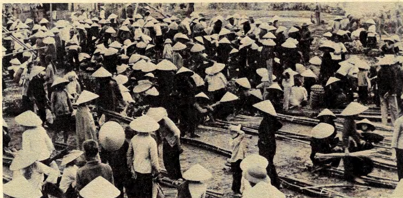
42.000 ruller med spanskrør er blitt bært fra jungelen til de sentrale delene av øya
